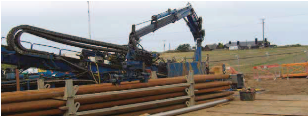
Example HDD rig
